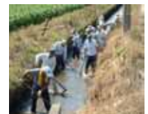
水路の泥上げ
