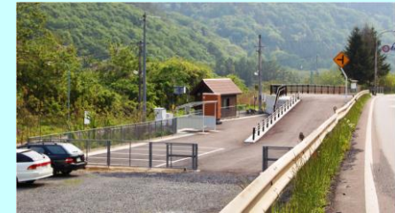
岩根橋駅前広場整備
