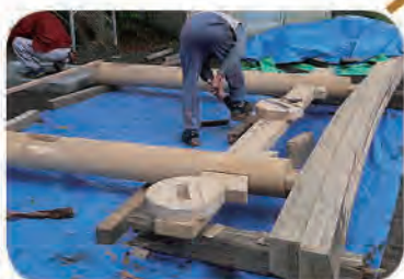
④ 境内に材料搬入・組み立て
