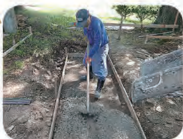
③ 基礎工事
