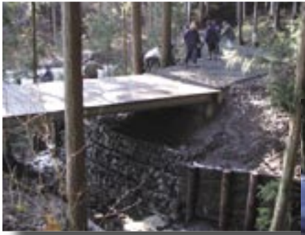
架け替え後の橋
