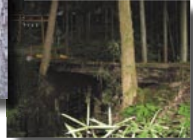
架け替え前の橋
