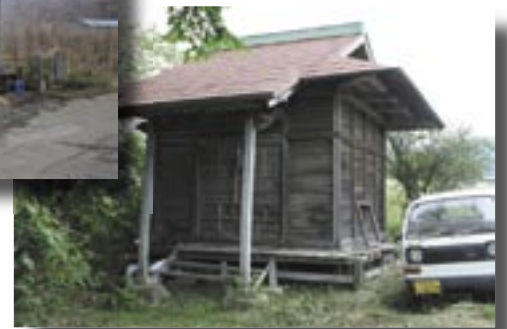
修復前のお堂
