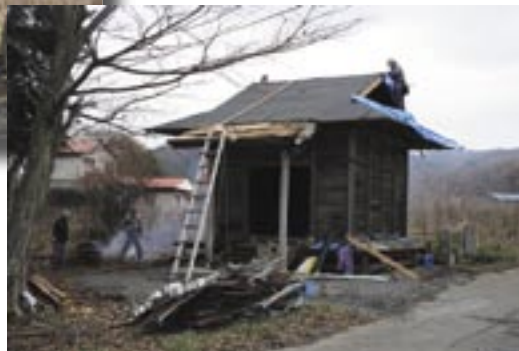
修復中のお堂
