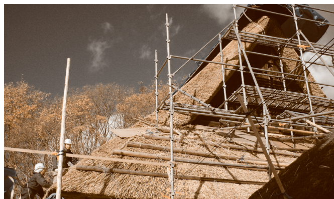
▲新年度は伝承園のかやぶき屋根を改修予定
