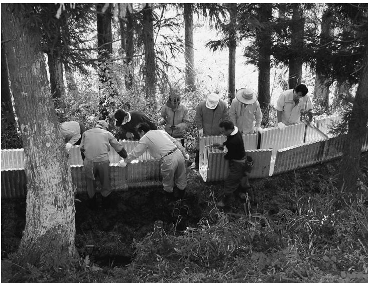
大沢地区水路整備の作業風景
