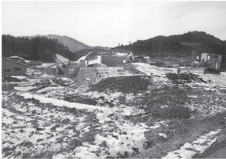
宮守インターチェンジ付近の建設風景
