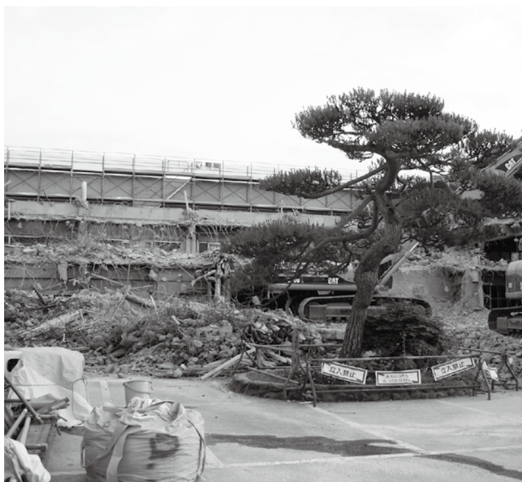
解体工事が進む市庁舎中央館
