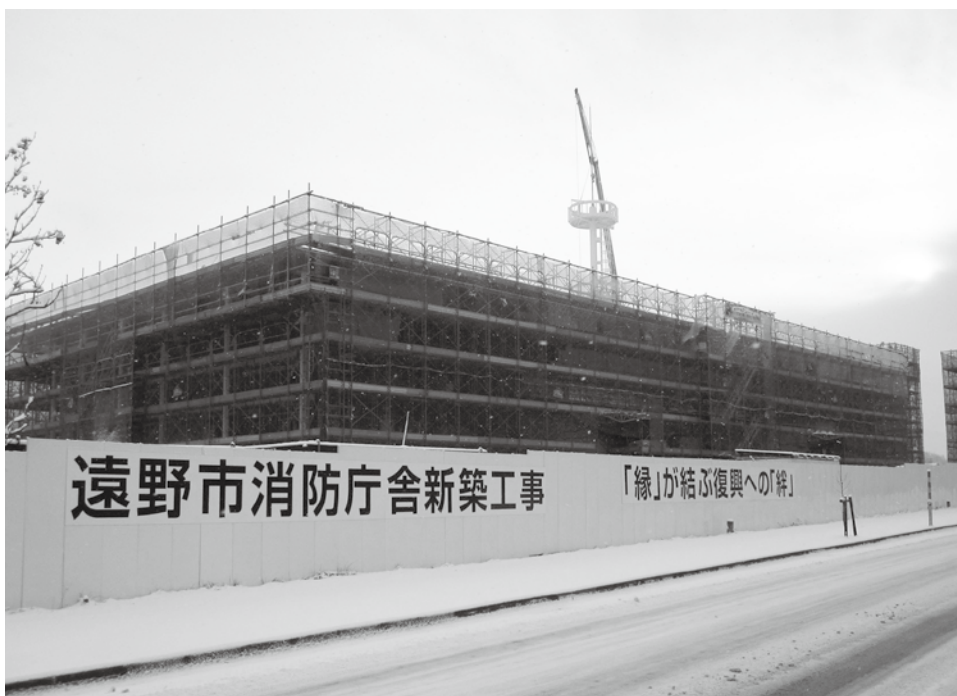
公約実現の一環として整備中の防災センター
