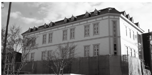
完成間近のまちおこしセンター
