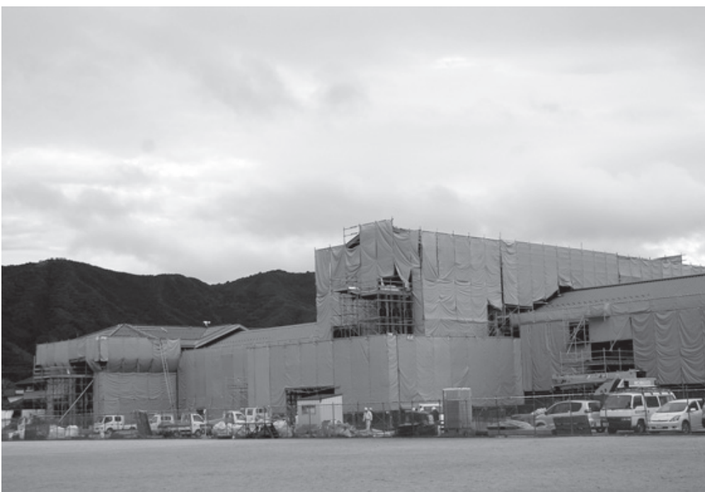
来春の再編成に向け、工事が進んでいる新生遠野中学校
