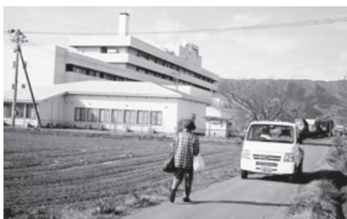
早期整備が望まれる狭小な県立遠野病院周辺の道路
