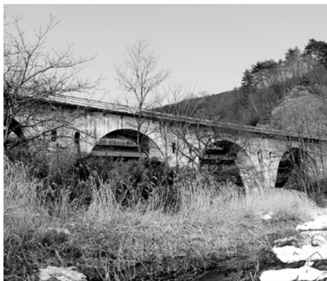
宮澤賢治の「銀河鉄道の夜」のモデルとされる達曾部川橋梁(岩根橋)
