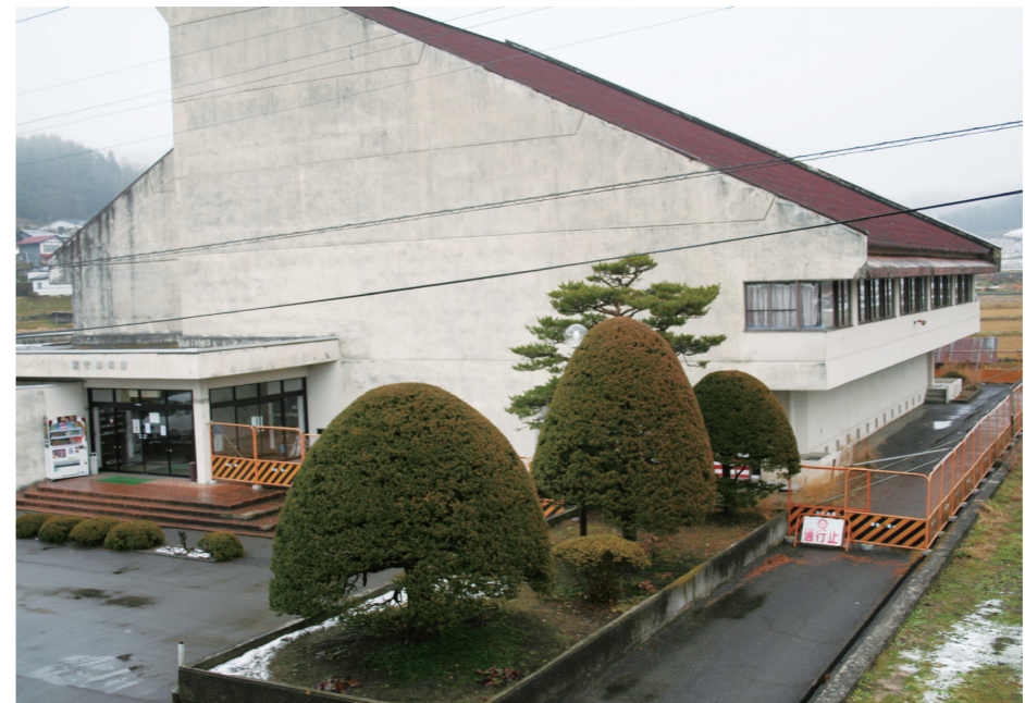
老朽化対策が求められる公共施設（写真：宮守体育館）
