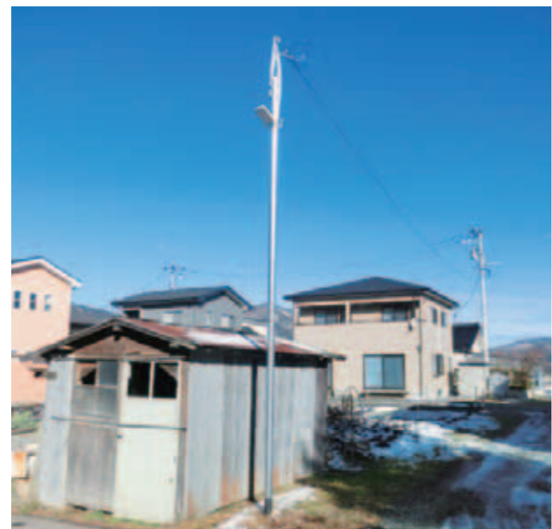
電気料金が安くなり、カメムシ被害も軽減されるLEDの防犯灯
