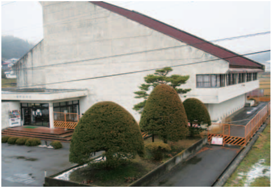
老朽化対策が求められる公共施設 (写真:宮守体育館)
