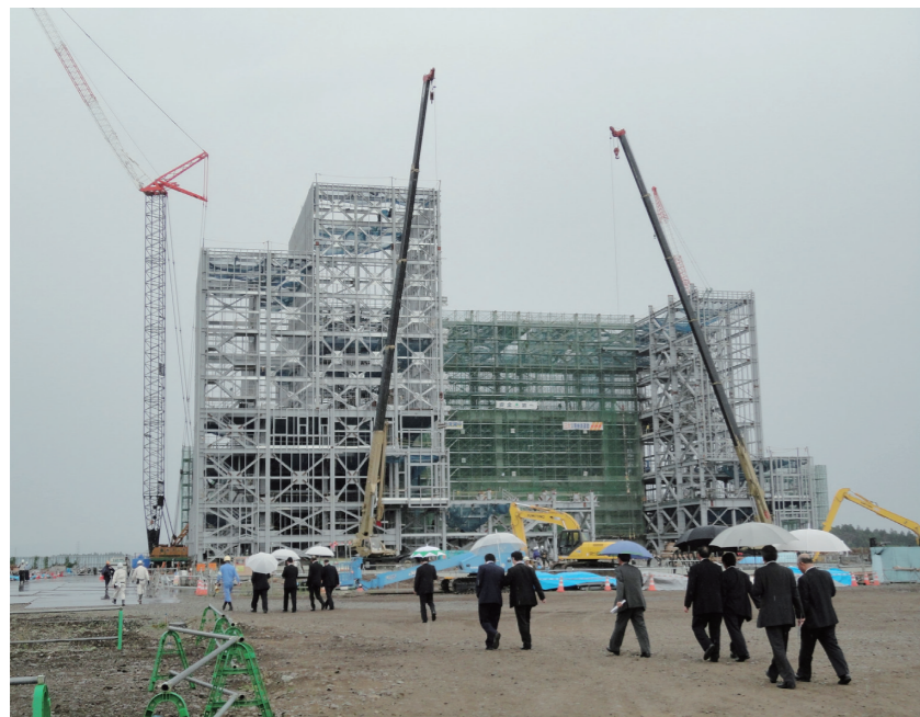
建設中の新クリーンセンター
