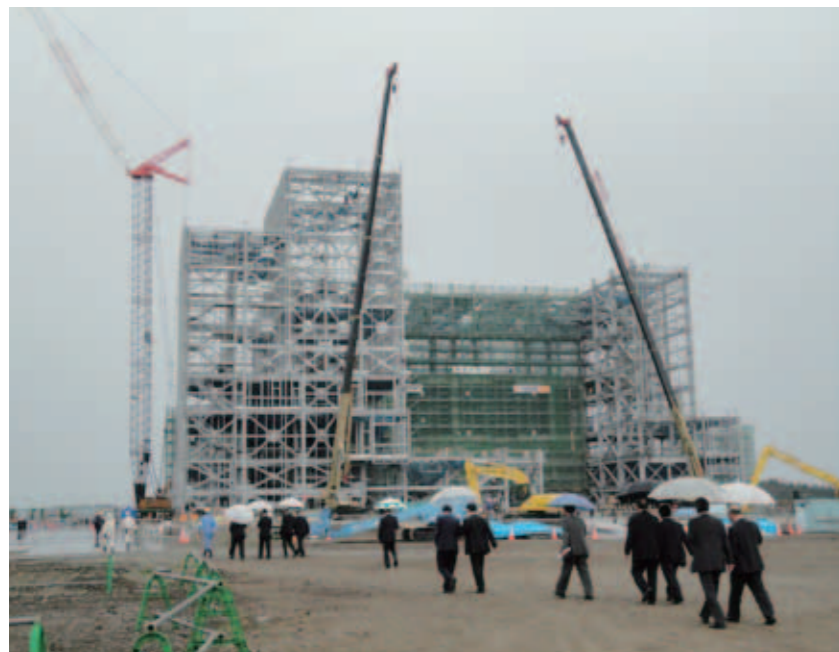
建設中の新クリーンセンター
