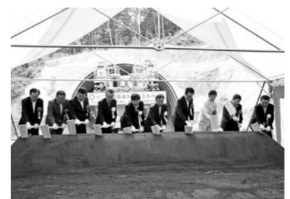
工事の安全を祈り鉄入れする関係者ら
