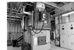
右／大型機械を導入し、不要な木材をチップ化上／木質チップは、燃料として専用のボイラーで使用されます
