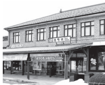
建て替え予定の遠野駅舎
