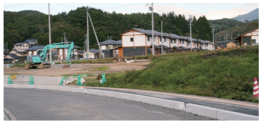
工事が進められている稲荷下地区
