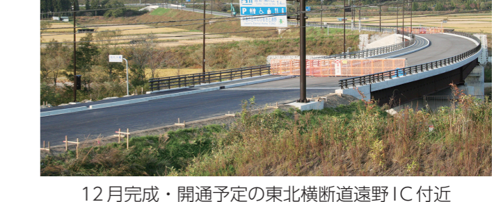
12月完成・開通予定の東北横断道遠野IC付近
