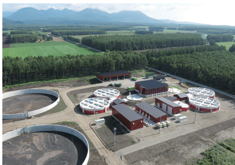
今年4月から稼動した国内最大規模のバイオガスプラントの全景
