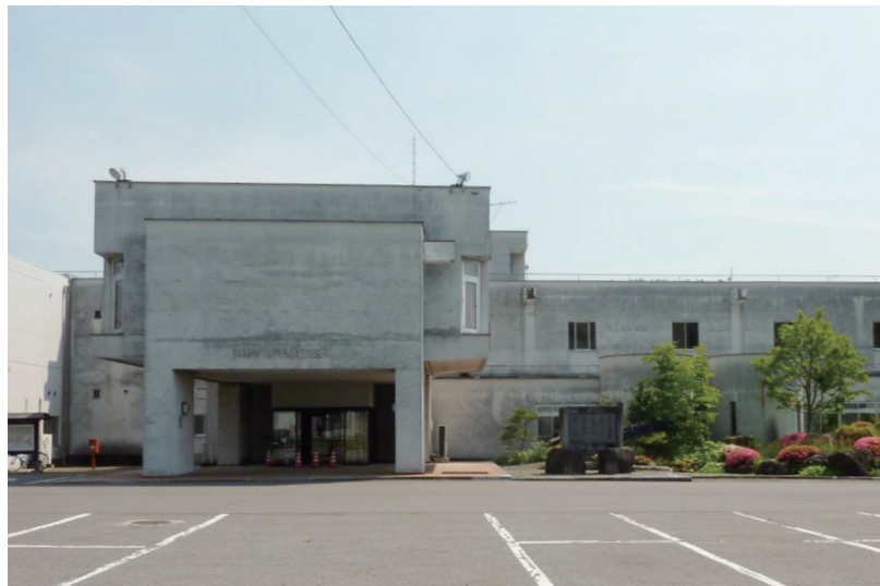
議会機能の新庁舎移転後、2階フロアが(仮称)宮守千年の森歴史伝承館や会議室に改修予定の宮守総合支所
