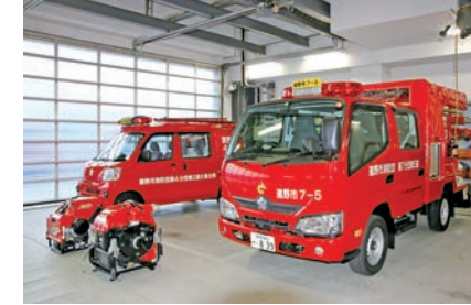
新たに配置された車両とポンプ
