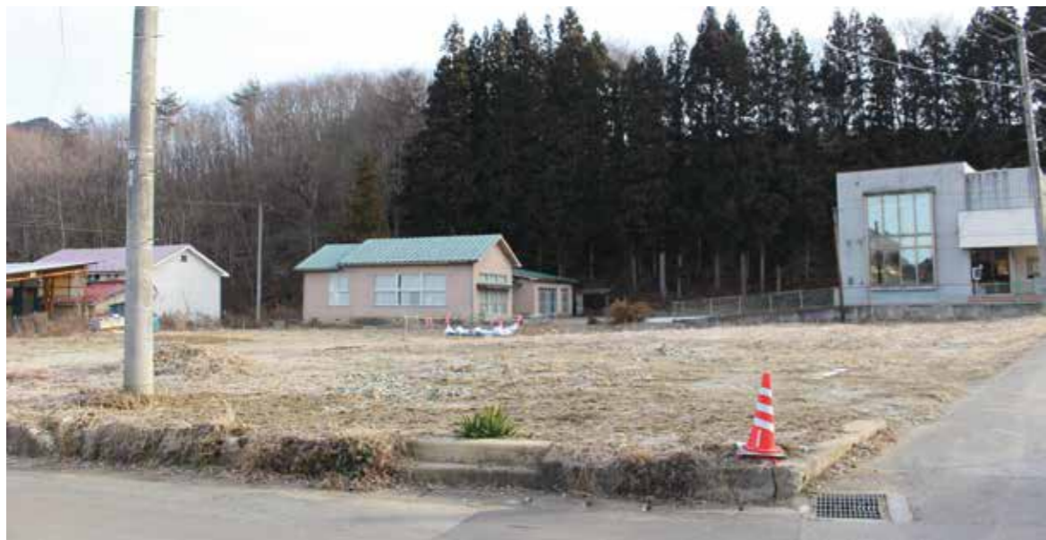
早い整備が望まれる鱒沢地区センター建設予定地
