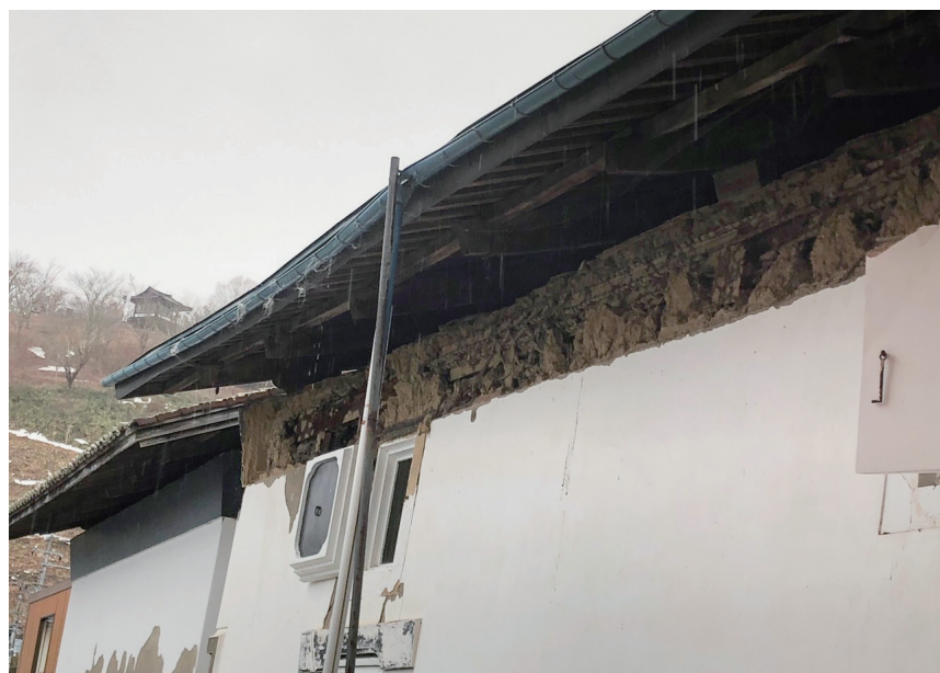
安全面・景観面から改修する土蔵
