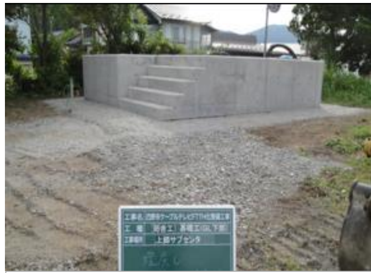
サブセンター基礎工事(上郷)
