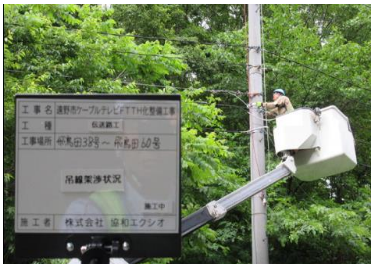
光ファイバケーブル設置作業
