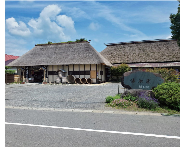
老朽化により食堂と厨房を改修予定の伝承園
