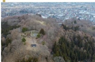
山頂を切り崩して造られた平地。建物があった場所。(写真_鍋倉上空南から)
