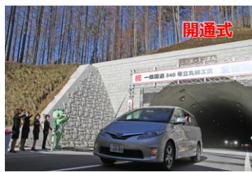
交通の難所のトンネル化で宮古⇄遠野間の交通量増加
