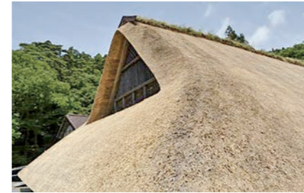
完成した旧千葉家住宅の茅葺屋根。全て遠野産の茅で葺き替えられた
