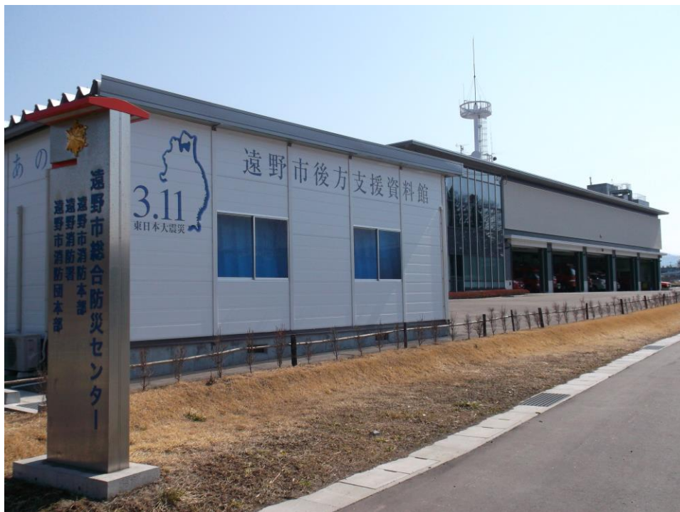
遠野市後方支援資料館と遠野市総合防災センター
