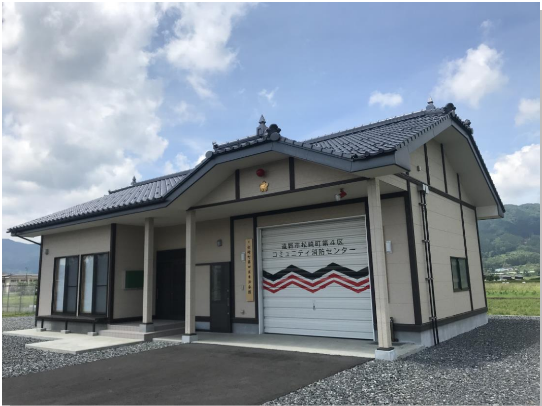
松崎町第4区コミュニティ消防センター 平成31年3月 竣工
