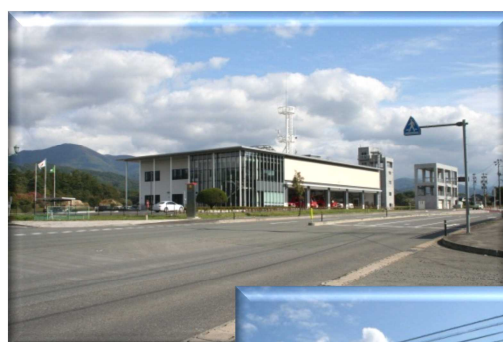
H24.7 完成 総合防災センター
