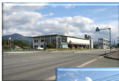
H24.7 完成 総合防災センター
