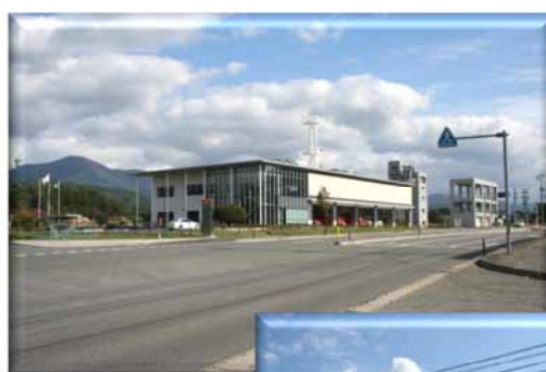
H24.7 完成 総合防災センター
